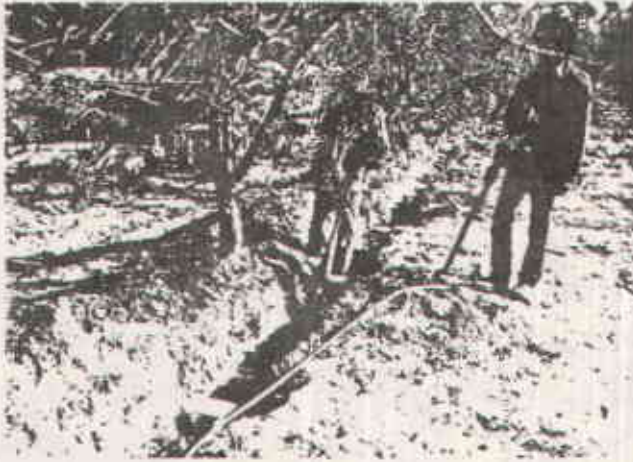
شكل رقم (٥) تبين الانبوب البلاستيكي المعد لايصال الجرار بعضها ببعض لتكوين شبكة الري بالجرار
